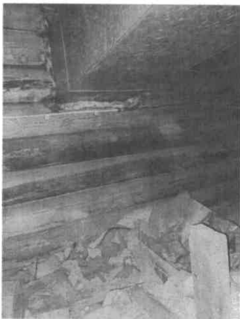
Kuva 7. Rukoussalin poistoilmakanavan ja huippuimurin sähkösyötön vienti päädyssä piippuun.
