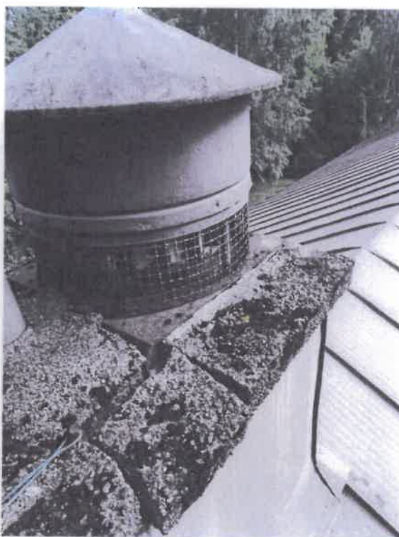
kuva 14. Huippumuri ja halkeillut piipun hattu.
